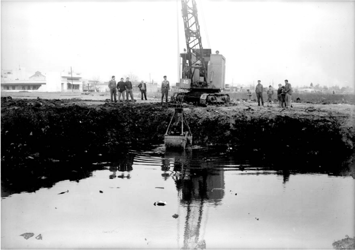
Fig. 2. Soil removal as part of the Parque Almirante Brown. Source: Archivo Fotográfico de la Subsecretaría de Planeamiento "Alberto Aquilino López", Gobierno de la Ciudad de Buenos Aires.
